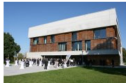
Vielberth-Gebäude: Ansicht von Westen
