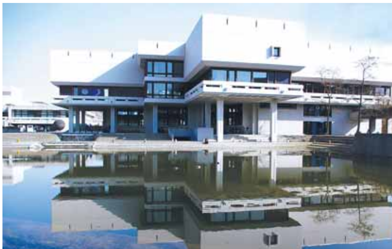
Die Zentralbibliothek der Universität Regensburg grenzt an einen kleinen Teich. Einzig bei der Ausstattung zeigten sich die Studenten mit dem Sieger in der Gesamtkategorie nicht ganz zufrieden und vergaben nur ein „befriedigend“. Aber ein Neubau ist bereits in Planung. Bild: Universität Regensburg
